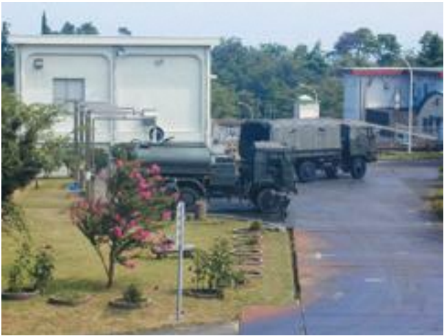
赤坂山浄水場緊急時給水施設
